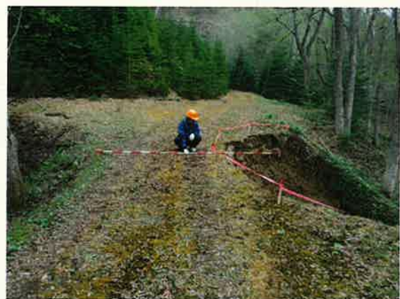
路網点検状況
