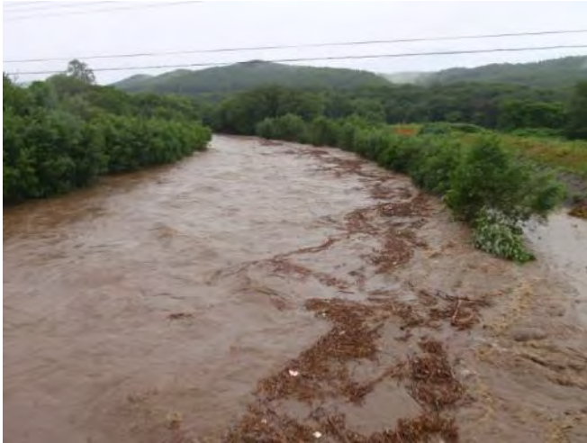
H26.8.5_興部川出水状況
