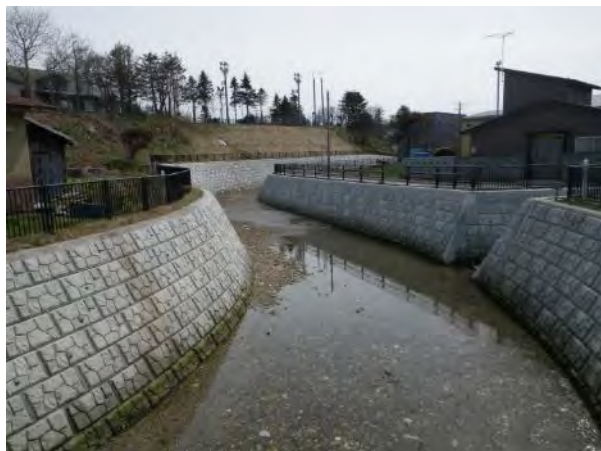
杓ツナ川改修状況
