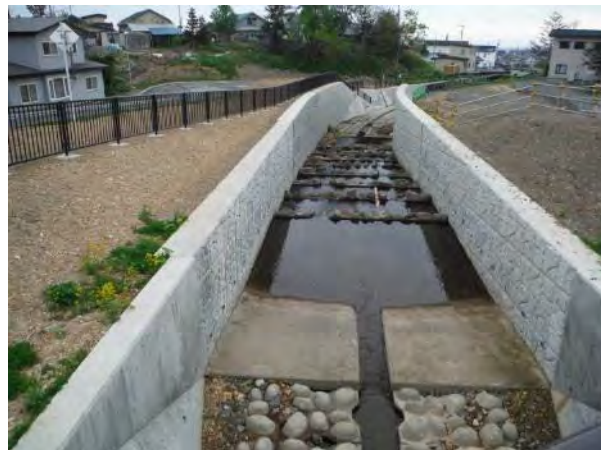
ホノ杓ツナ川改修状況
