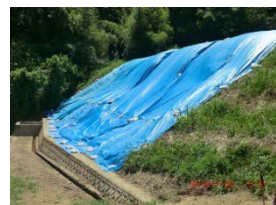
ブルーシートによる被災箇所の保護
