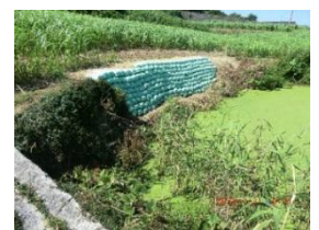
土のうによる崩落箇所の拡大防止
