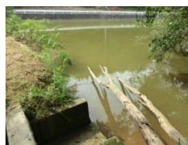
土砂や流木等の撤去
