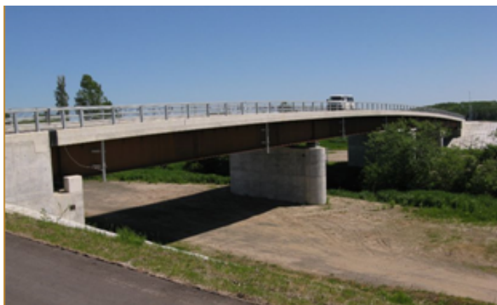
北見端野美幌線(花見橋)(美幌町)
