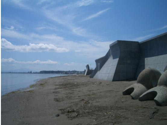
網走海岸明治地区 高潮対策工事（道州）（網走市）
