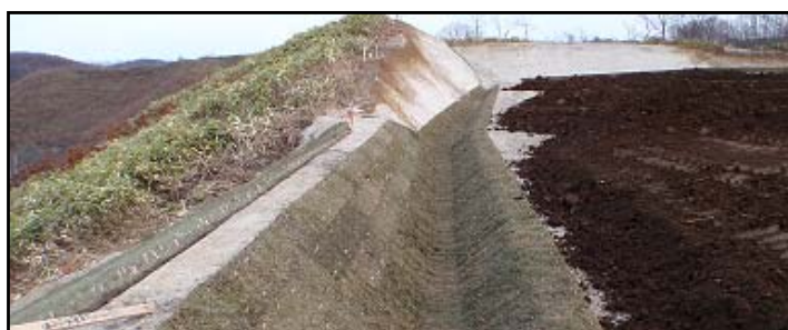
張芝水路施工事例
