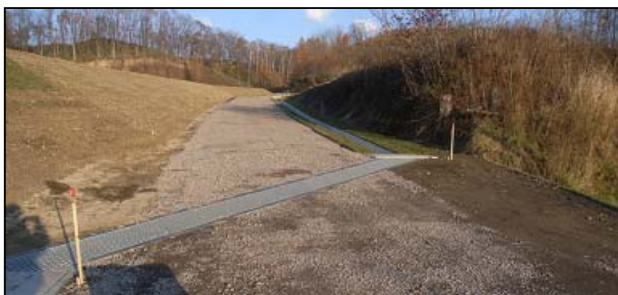
取付道路横断トラフ設置事例
