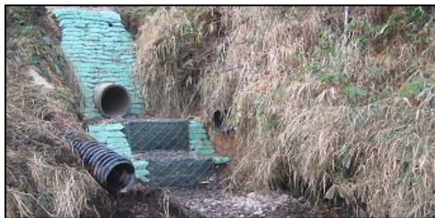
流末水叩き部の設置事例
