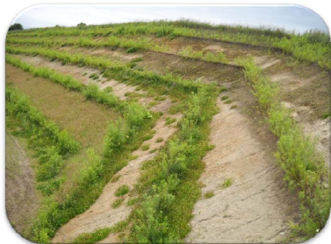
帯梢段柵工施工例
