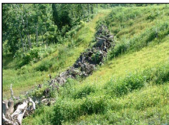
伐開物・伐根物等を法尻に活用
