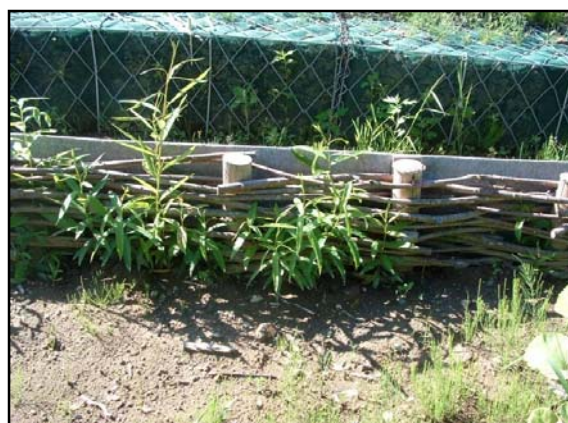
法尻に帯梢段柵工とフトン籠を設置
