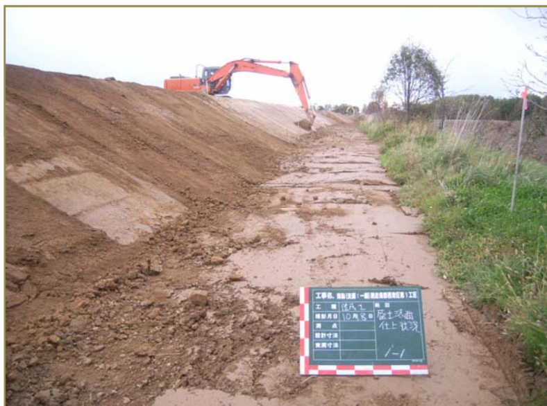
バックホウによる法面整形状況
