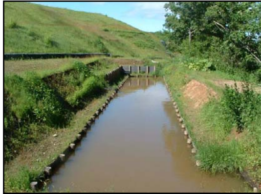
地山を掘削して沈砂池を設置
