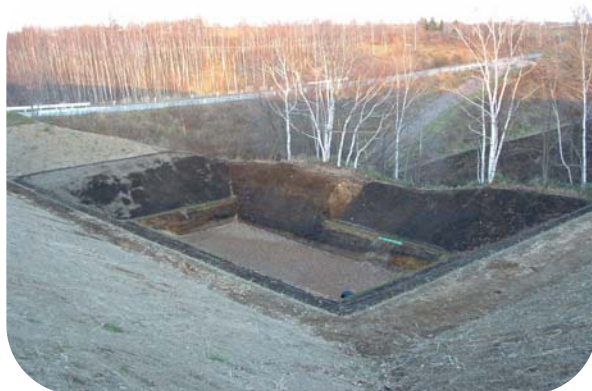
沢地形側の法面部は安全な幅(厚み)が必要 (浸透型沈砂池)
