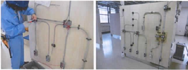
配電制御盤実習
