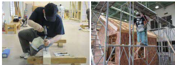
継ぎ手・仕口製作
