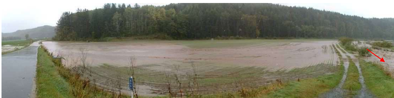
<ルクシニコロ川 氾濫状況（浅尾橋上流） 平成 18 年 10 月>
