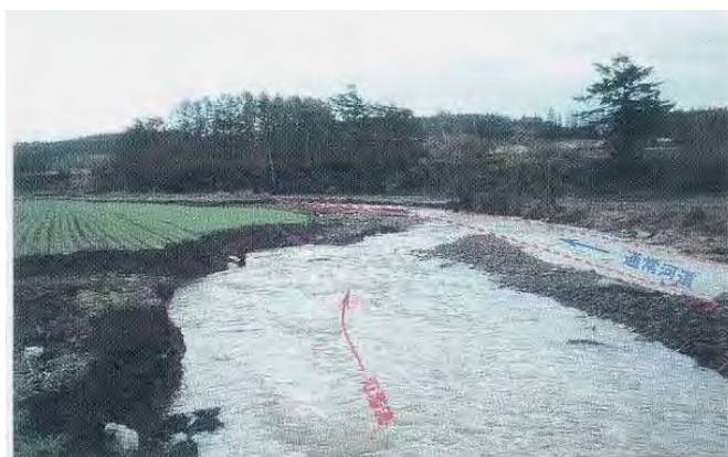
<ポンニコロ川 氾濫状況（1号橋下流付近） 平成 18 年 10 月>
