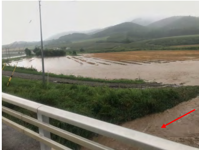
＜パンケビバウシ川 氾濫状況（大曲橋上流） 令和 5 年 8 月＞
