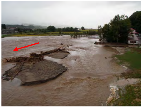
＜無加川氾濫状況（水郷大橋上流） 平成 28 年 8 月＞
