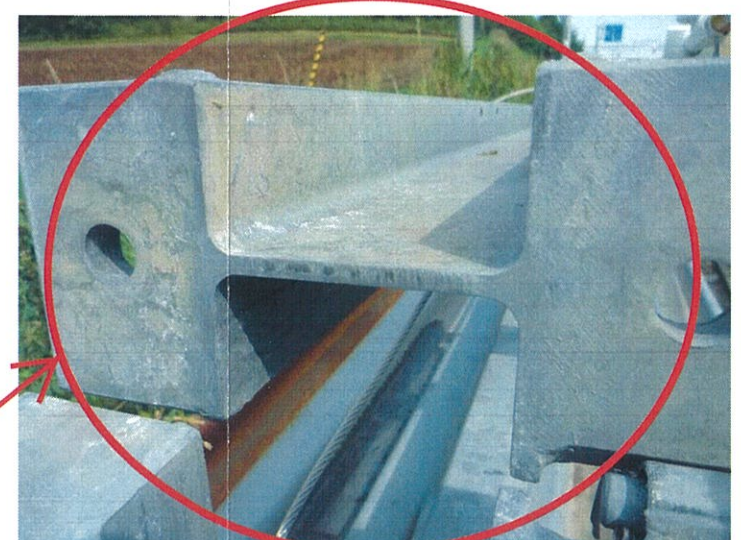
上部支柱（H-100）とベース溶接部
