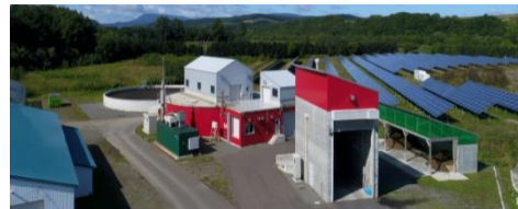
興部北興バイオガスプラント
