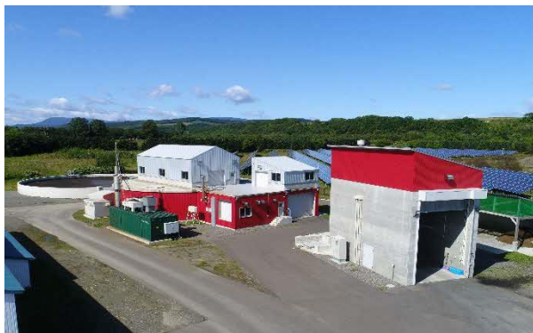
興部北興バイオガスプラント
