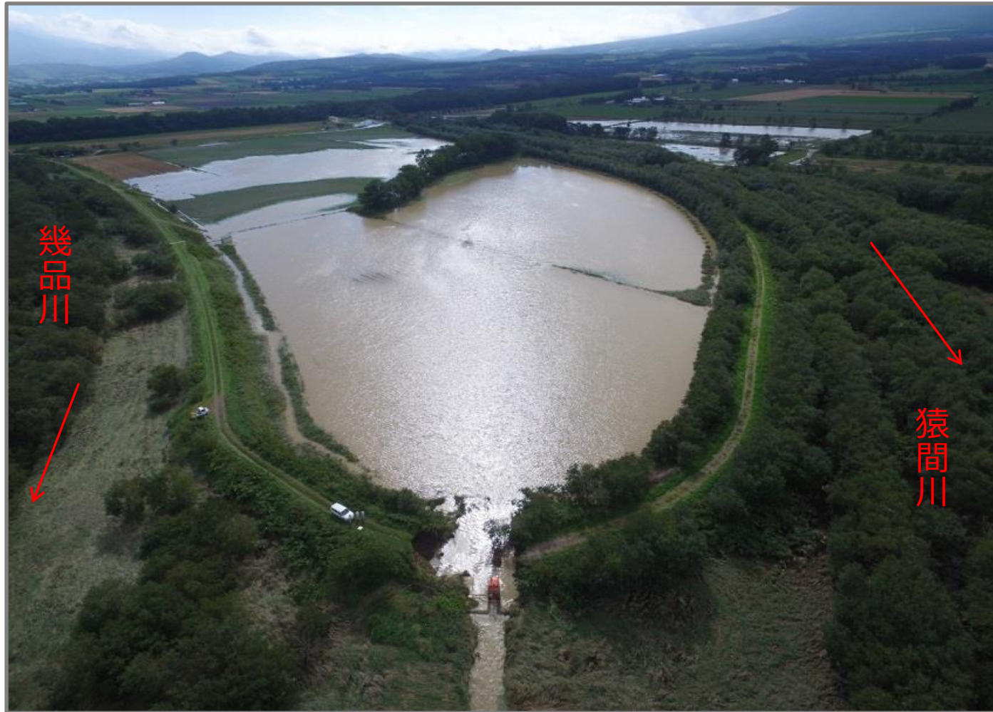
斜里町花渚樋門の破堤状況
