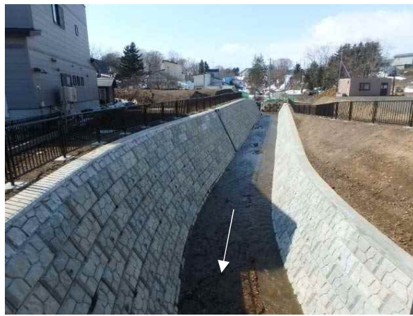
ポンオコツナイ川【掘削(改修)】
