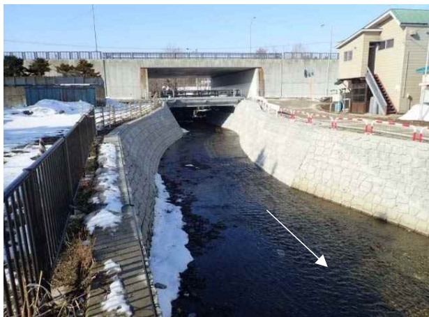
オコツナイ川【掘削(改修)】
