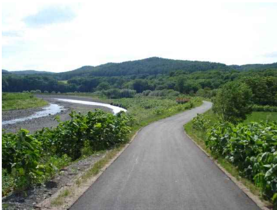
興部川堤防天端舗装
