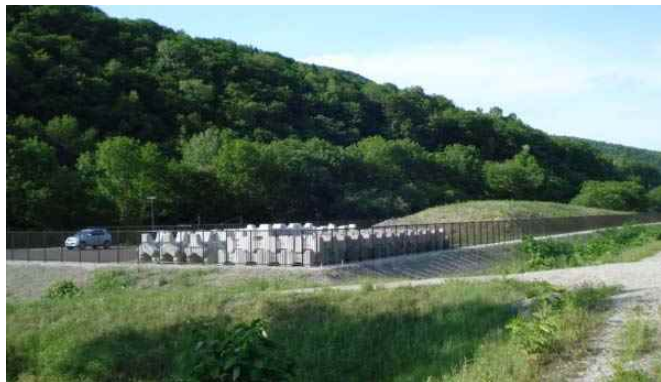
興部川防災資材備蓄ヤード
