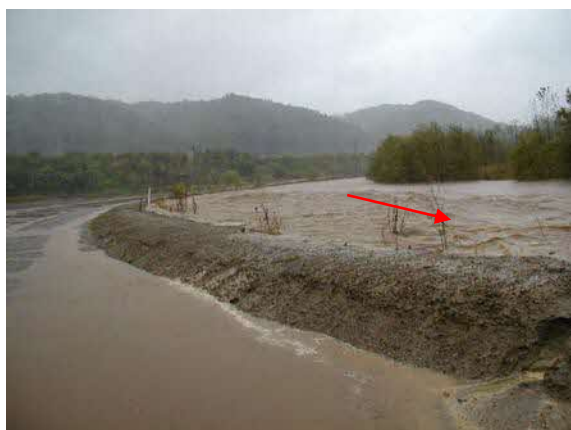
写真－ 2 (3) 網走川氾濫状況 (平成 18 年 10 月洪水)
