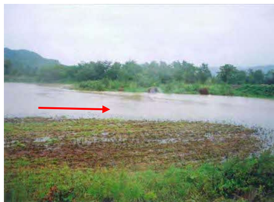
写真－ 2 (2) 網走川氾濫状況 (平成 13 年 9 月洪水)
