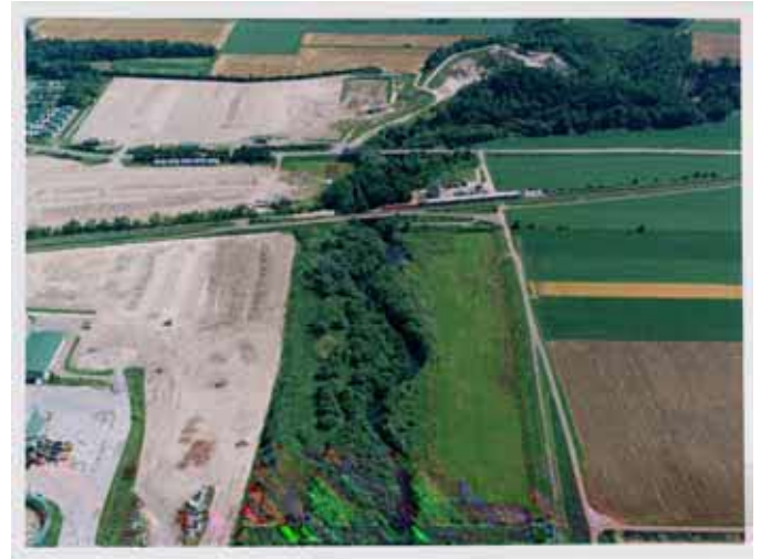
斜里川 JR 橋上下流
