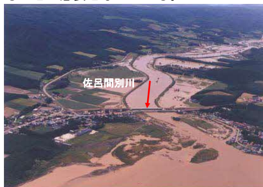
サロマ湖合流点付近の浸水状況
