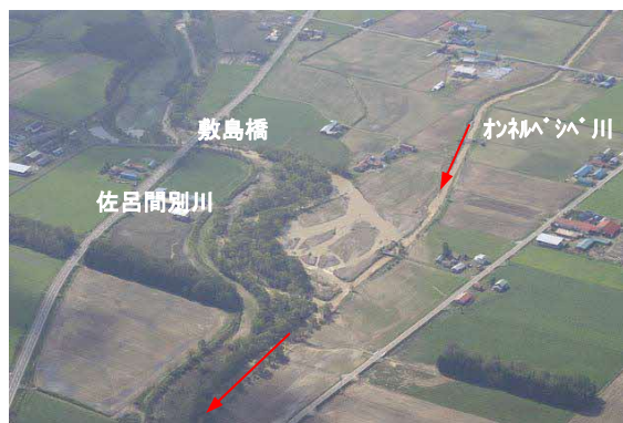
敷島橋下流の浸水状況
