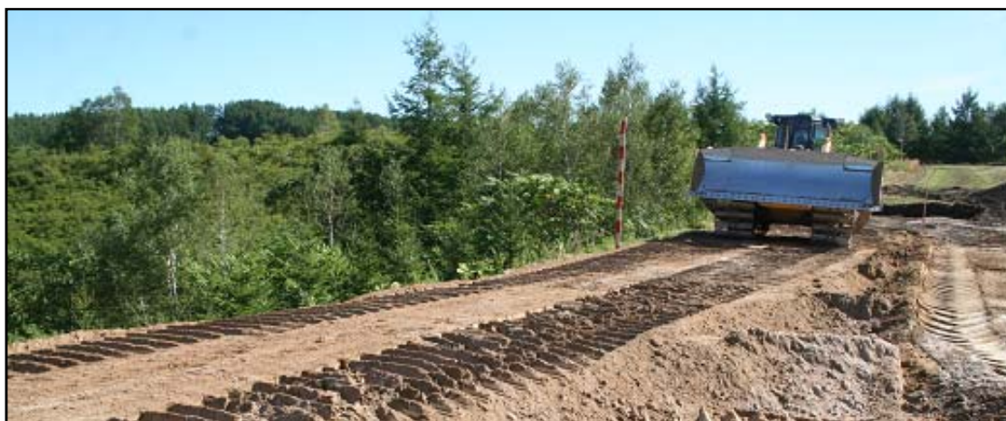
盛土層状転圧状況
