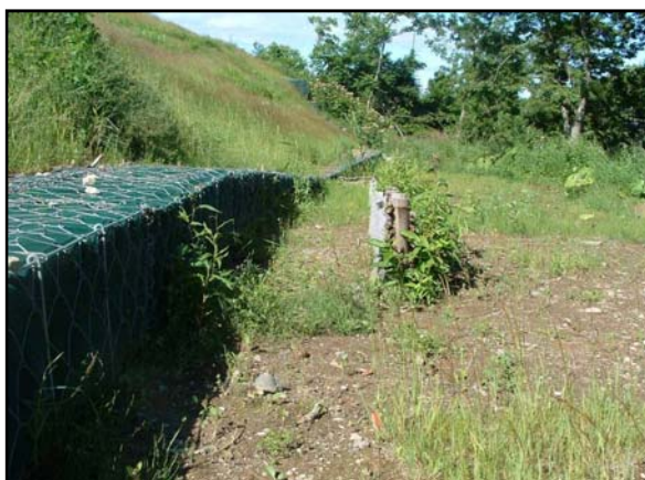
盛高H=10mを超える盛土における土砂流出防止対策の一事例 —法尻に帯梢段柵及びフトン籠を設置—
