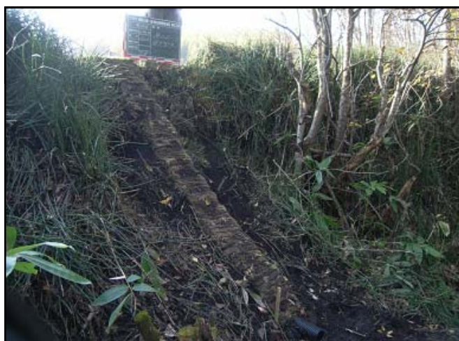
暗渠排水落口施工例
