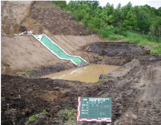
客土土取場沈砂池設置例
