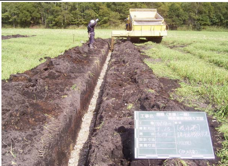
暗渠排水施工状況
