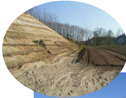
客土土取場 法面保護工 施工前
