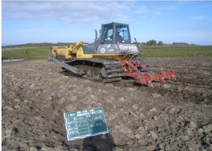
心土破碎施工状況
