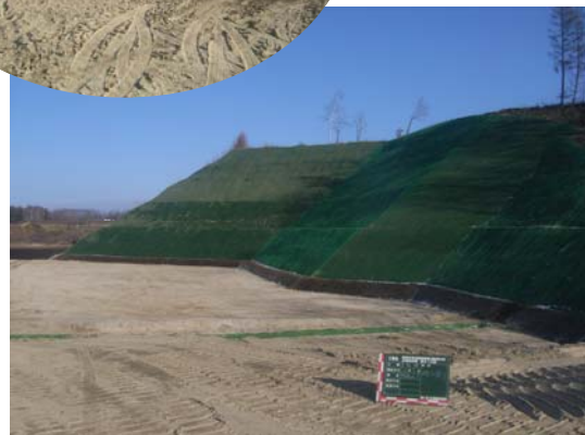
客土土取場法面保護工施工後 （伐開物による法覆基材工）
