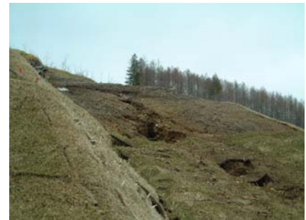
法面侵食の例
