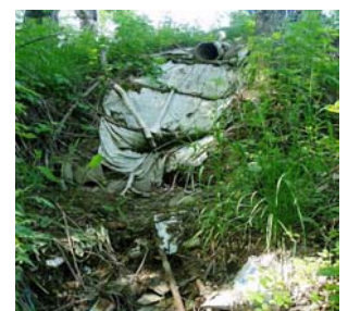
流末処理が行われず侵食が生じた斜面
