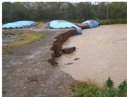
川沿いの農地で生じた溪岸侵食
