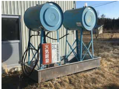
燃料タンクに設置した 防油堤 (訓子府町)
