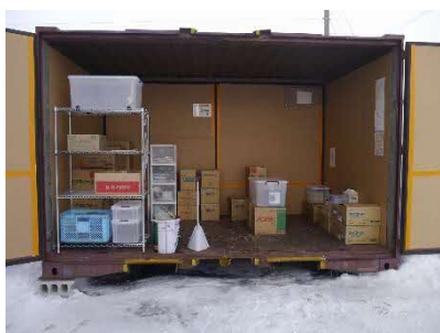
JRコンテナを利用した農薬保管庫（保 管庫内の右上の換気口は自作で取り付け た）（湧別町）
