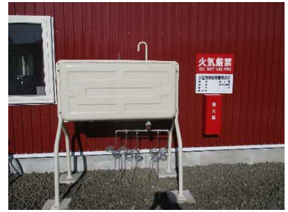
燃料タンクと消火器 (湧別町)
