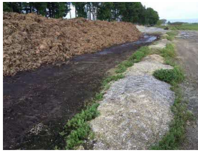
堆肥の流出対策として堆積場所 周辺に盛り土を施工（湧別町）
