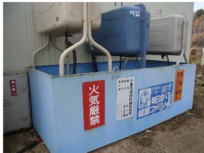
中古の水槽を加工し安価に 設置した防油堤 (津別町)
