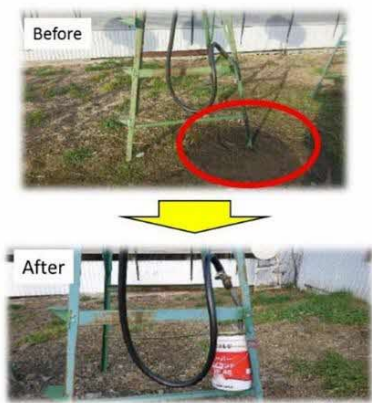
ノズルからの燃料漏れの対策として オイル缶を設置 (佐呂間町)
