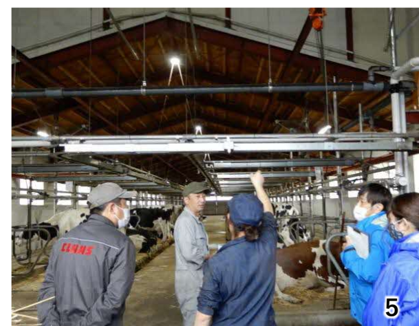
5. 搾乳舎は鉄骨等は頭をぶつけない高さで設計。ミルクラインも地下に埋め込み式にした。
