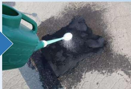
マイルドパッチ(水との反応により硬化するアルファルト材)で補修して改善!
