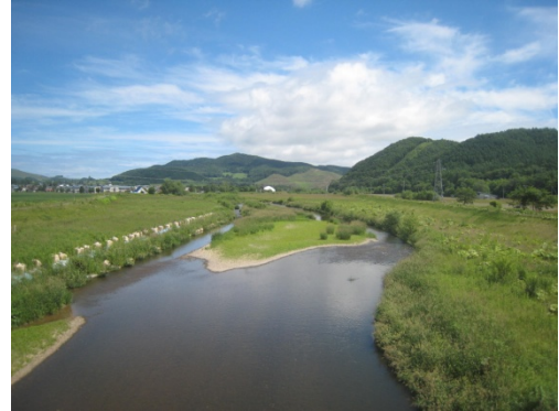
佐呂間別川改修工事（佐呂間町）
