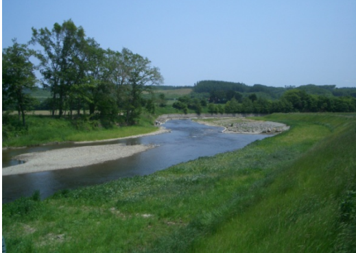
網走川改修工事（津別町）
