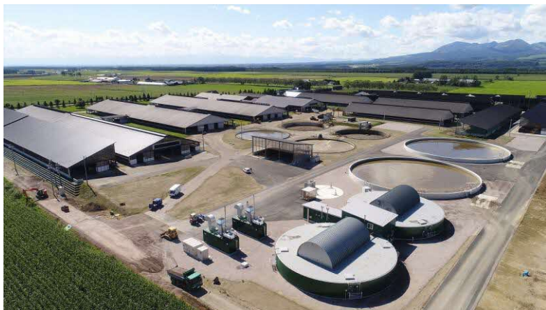
バイオガスプラント
