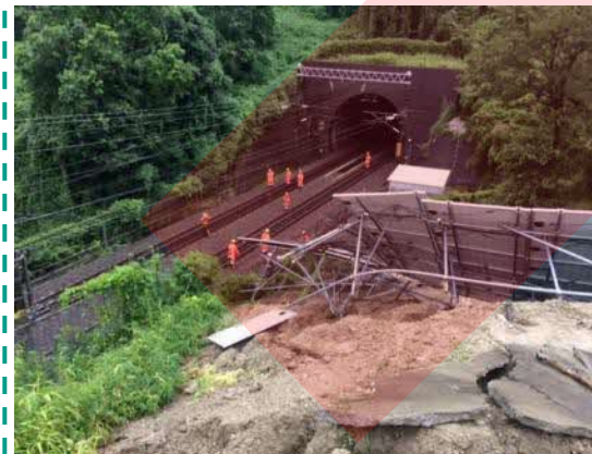
新幹線近くの斜面上部に設置された太陽光発電施設が崩落した事例
