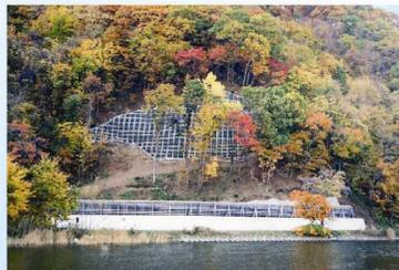
崩壊した斜面を復旧し、擁壁により傾斜を緩くして、土砂を安定させます。
