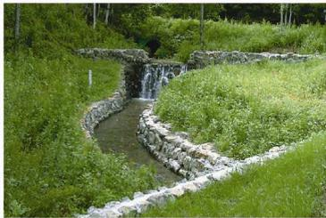
河岸の浸食を防止し、土砂の流出を防ぎます。
