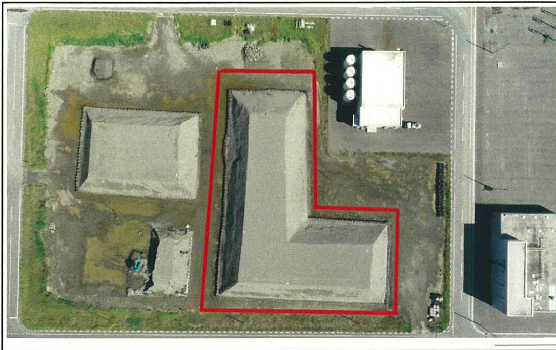
常呂漁港浚渫土
