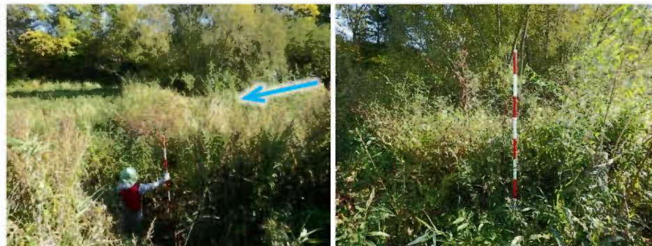
下流側ハイドロバリア水制工
