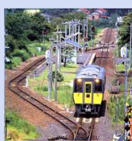
行き違い設備改良
