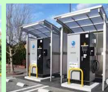
EVバス充電施設の設置
