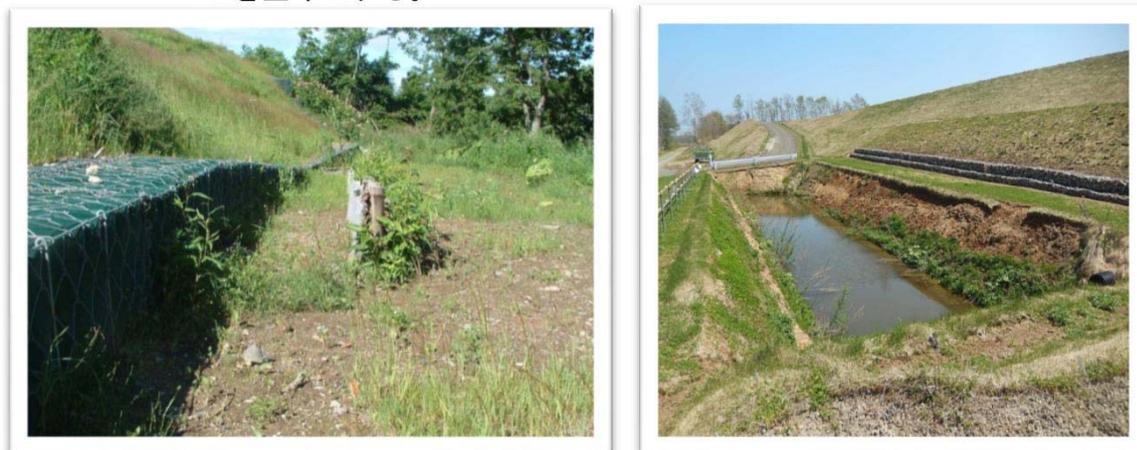
盛高H=10mを超える盛土における土砂流出防止対策の一事例
