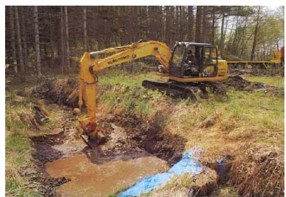
沈砂池に堆積した土の土砂上げ
