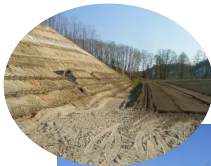
客土土取場 法面保護工 施工前
