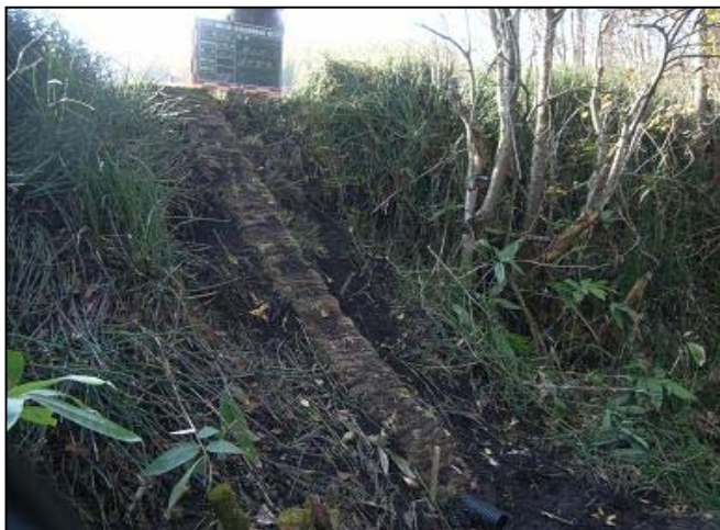
暗渠排水落口施工例
