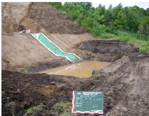
客土土取場沈砂池設置例
