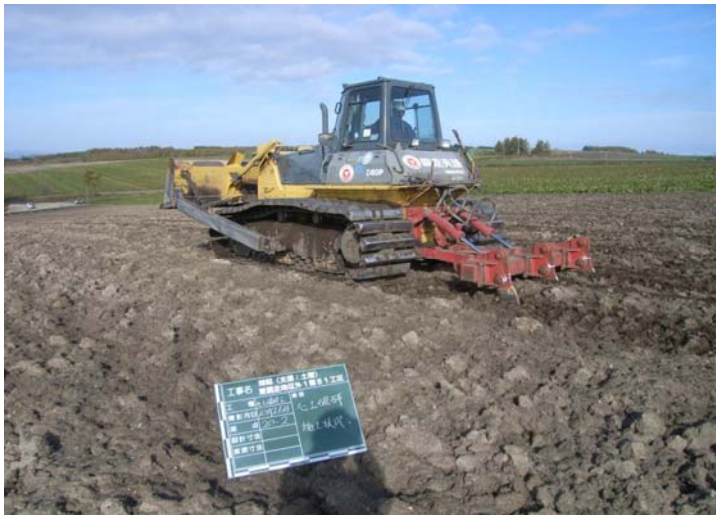
心土破碎施工状況
