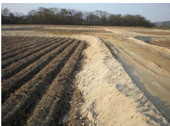
客土材の帯置状況
